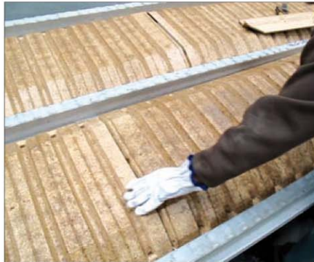
Emboîtement de deux EBS sans coupe du bouchon
