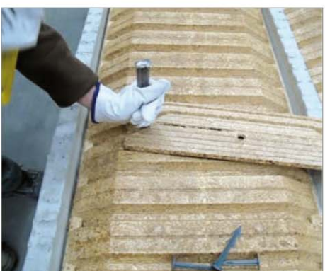
Séparation du tympan pour rupteur ES
