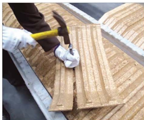
Coupe au burin (sécable)
