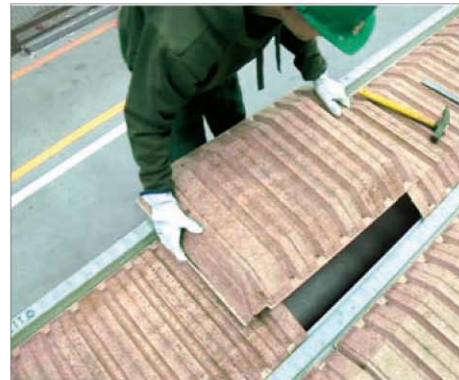
Ajustement dans sa longueur. Toujours couper le bouchon sur l'EBS d'ajustement qui vient en recouvrement sur les 2 autres
