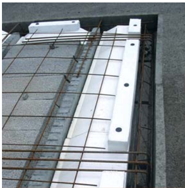
Plancher Hourdis Béton Rupteur Total : Stoptherm ES+EP
