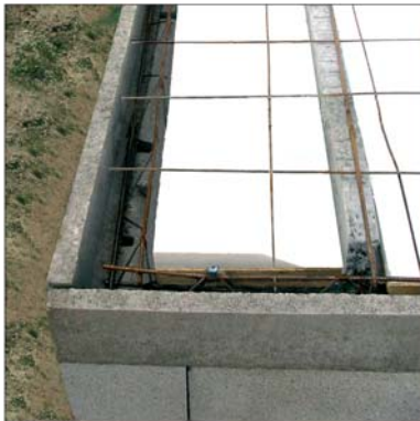
Plancher Hourdis Seacbois Rupteur Partiel : Stoptherm ES
