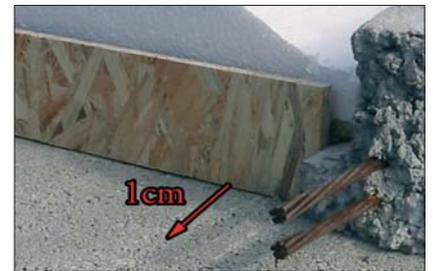
12 - Incliner les tympans de 1 cm environ pour une bonne tenue lors du coulage du béton.
