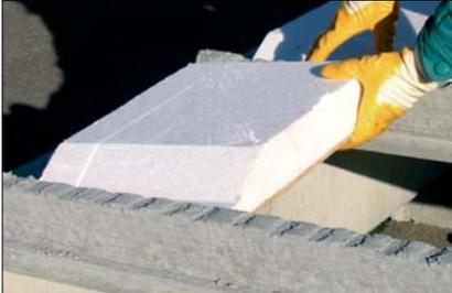
4 - Utiliser la chute pour démarrer la travée suivante (pas de pertes).
