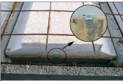
13 - Fixer les tympans en bout de travée grâce aux équerres de fixation.
