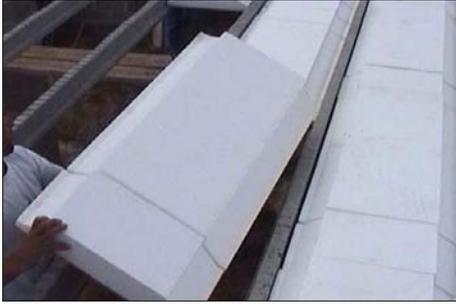
Mise en place des Seacbois par glissement sur les talons des poutrelles
