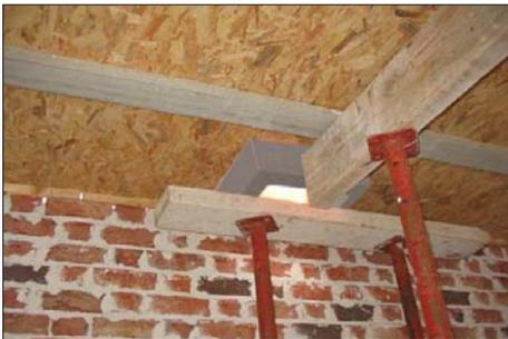
Boisseau de ventilation ou de cheminée en rive en gardant le rupteur thermique
