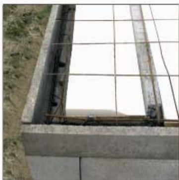
Plancher Hourdis Seacbois Rupteur Partiel : Stoptherm ES
