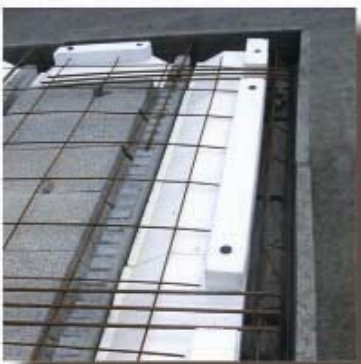
Plancher Hourdis Béton Rupteur Total : Stoptherm ES+EP
