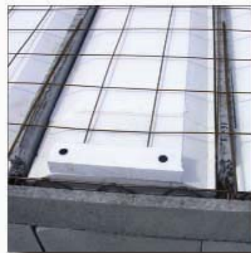
Plancher Hourdis Polystyrène Rupteur Total : Stoptherm EP
