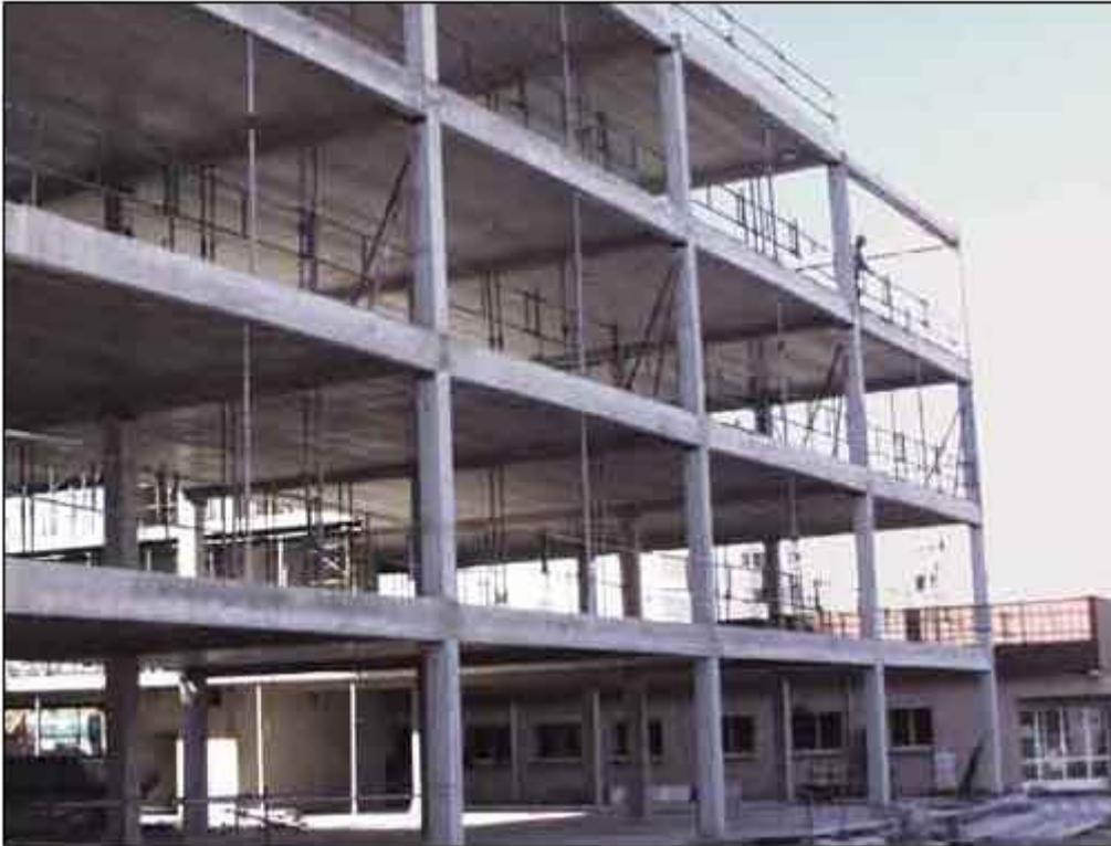
Les poutres de la structure béton seront de type poutre précontrainte SEAC ou similaire de section rectangulaire.
