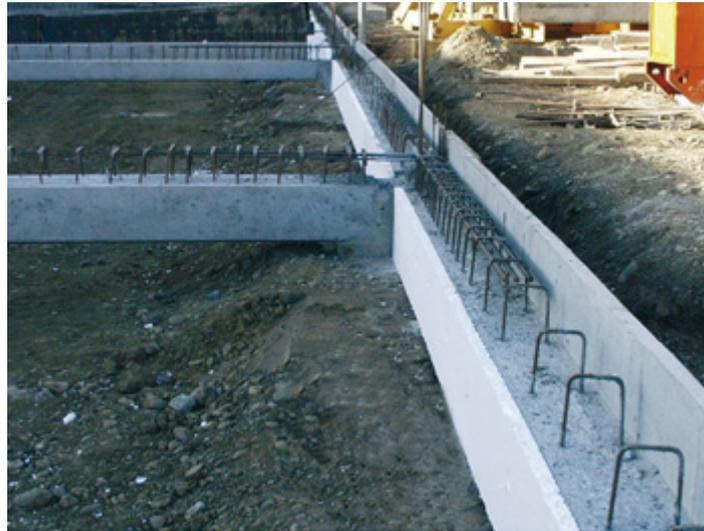
Les poutres de la structure béton seront de type poutre précontrainte SEAC ou similaire de section rectangulaire.
