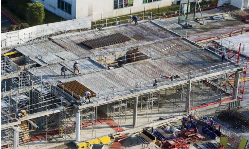
La dalle de plancher sera constituée d'une dalle béton coulée sur des prédalles pé contraintes de type prédalle SEAC ou similaire.
