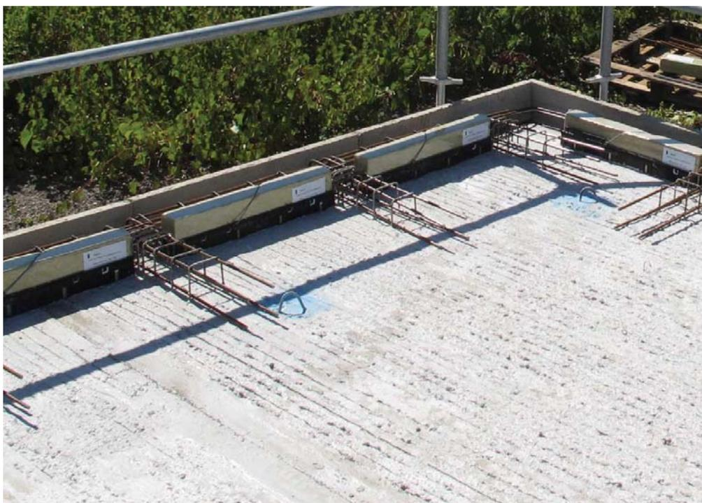
Le plancher sera constitué d'une dalle béton coulée sur des ThermoPrédalle<sup>®</sup> de type SEAC ou similaire intégrant un dispositif constitué de pains isolants positionnés dans leurs boîtes supports permettant la correction des ponts thermiques périphériques
