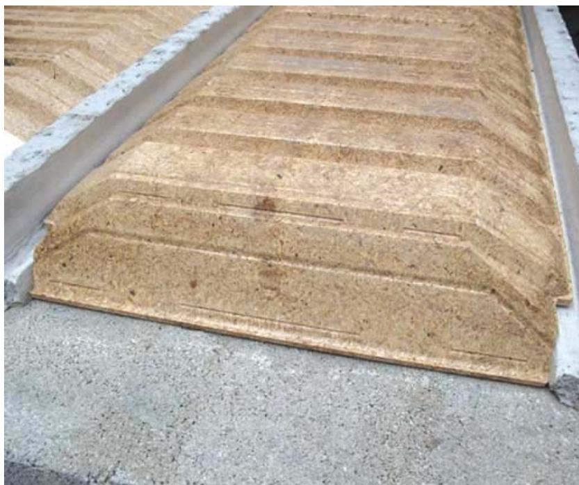
Les planchers seront constitués par un montage type SEAC ou similaire composé de poutrelles en béton précontraint et d'entrevous EBS.
